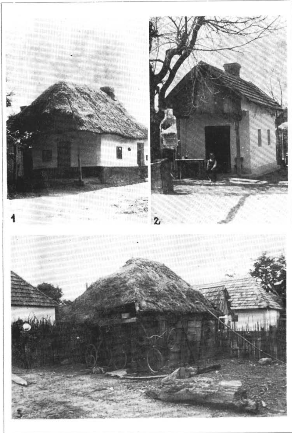
XXVII. t. Erdész: 1. Sütőház. Kisszekeres. 2. Nyári konyha. Nemesborzova. 3. Ereszes kamora, földes, sátoztetős. Botpalád.
