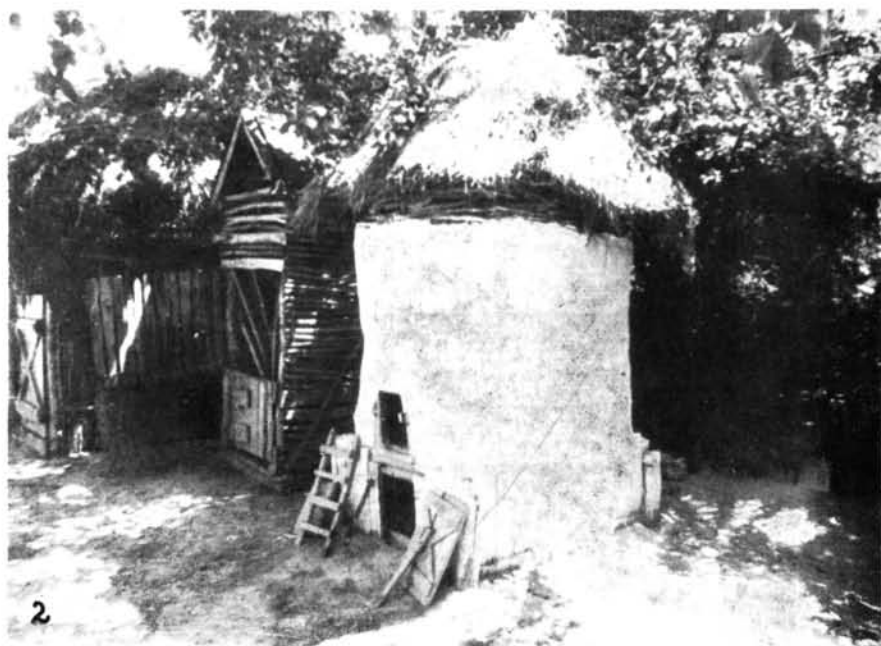
XXVI. t. Erdész: 1. Róttfa disznóól (fészkelte boronafal). Kispalád. 2 Vesszőfonatos, sártapasztásos tyúkgóré. Garbolc
