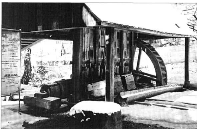
2. kép: 17. századi kőzúzó vízimalom a verespataki Bányászati Múzeumban
