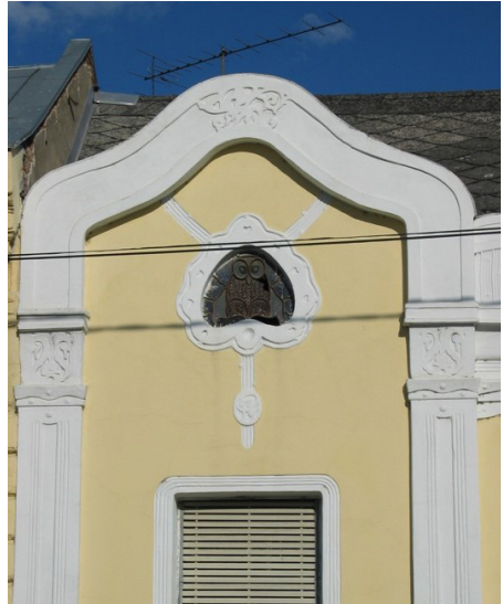
Az Alsó Víz utcában, ma is megcsodálható a Buzdugán házon az „üvegbagoly”.
