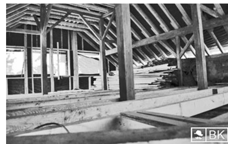
Félkész a tetőtér. Szeptemberre különleges kiállítás helyszíne lesz
