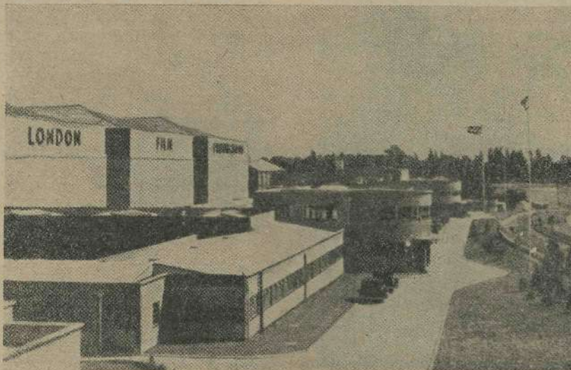
A Denham-stúdiók, előtérben a közigazgatási épületekkel
