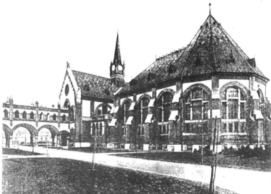
Összekötő folyosó és az északi épületszárny
