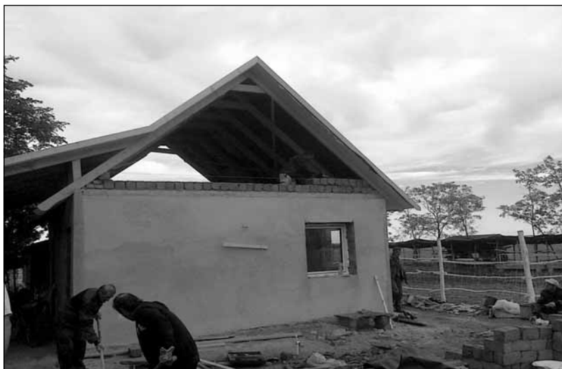
Saját vályogtéglából épülnek az állattartó telep épületei
