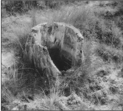
2. kép. Cementgyűrűs sós kút (Baszest - Basești, 2004)
