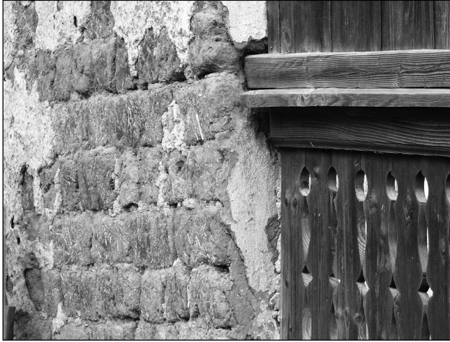
3. kép. Vályogfal és fűrészelt deszkamellvéd részlete Apában (Furu Árpád 2008.)
