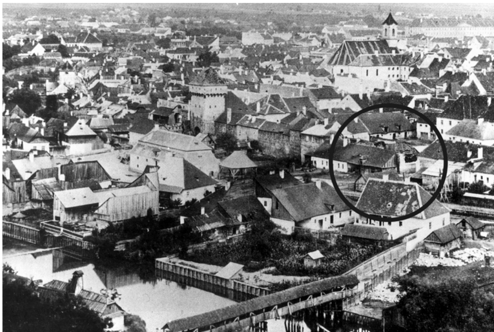
25. Veress Ferenc felvétele a Hídkapu környékéről. Az F1 területére eső szakaszon megfigyelhető, hogy a várfal elé is építkeztek
