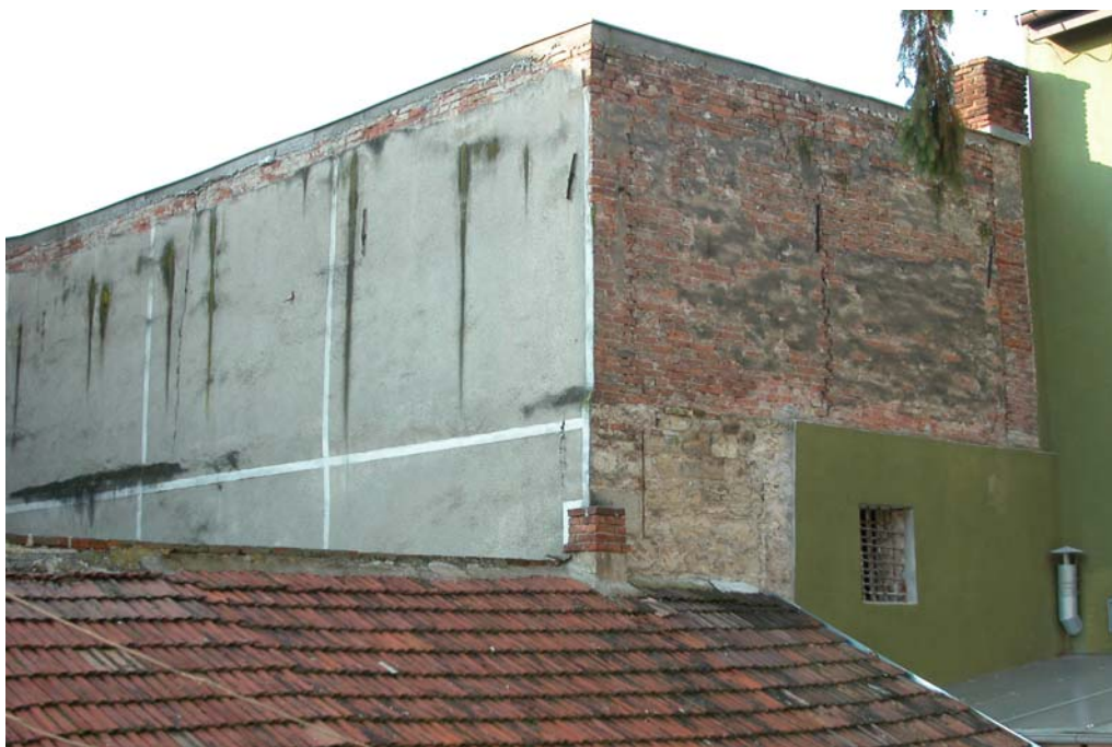
17. Az Óvár keleti fala. Megfigyelhető a tűzfalba foglalt várfal eredeti vastagsága. Híd (Regele Ferdinand) utca 7. sz.
