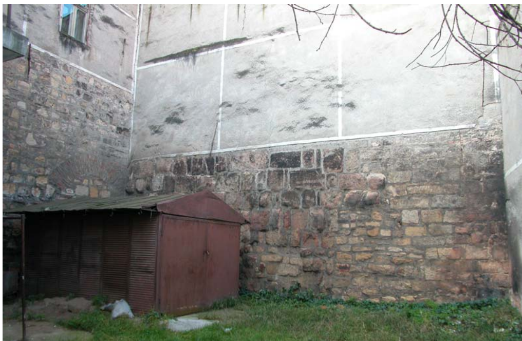
16. Az Óvár keleti falának külső síkja. Híd (Regele Ferdinand) utca 5. sz.
