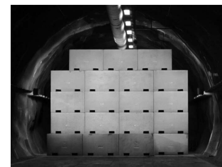
3. ábra • A Nemzeti Radioaktív Hulladék-tároló I-K1 tárolókamrájában véglegesen elhelyezett, radioaktív hulladékot tartalmazó vasbeton konténerek
