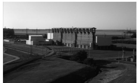
3. ábra • Kiégett fűtőelemek átmeneti tárolója
