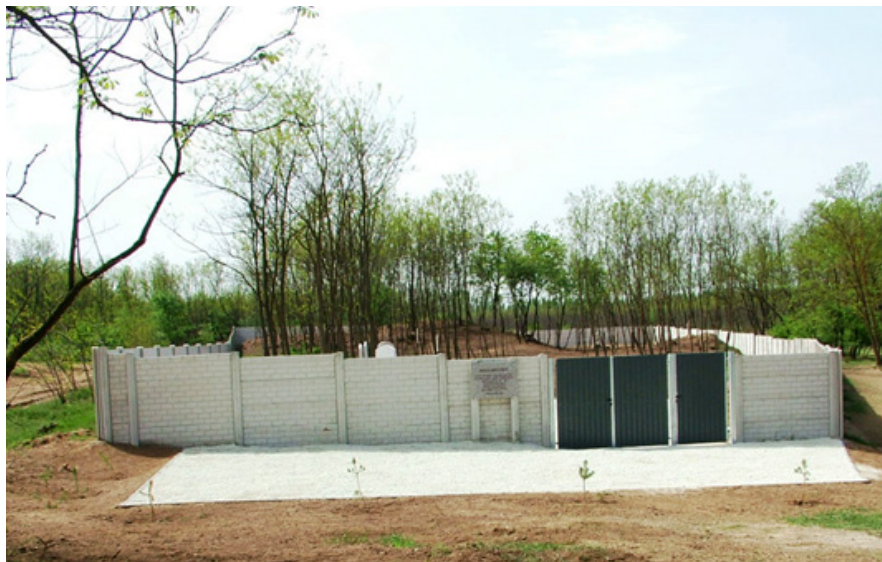
3. kép. Felújított zsidó temető betonkerítése (Kisléta)
