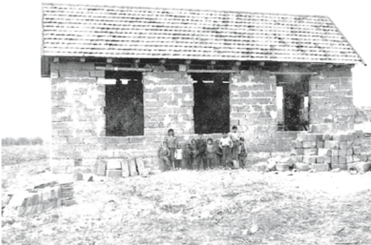
Épül az óvoda
