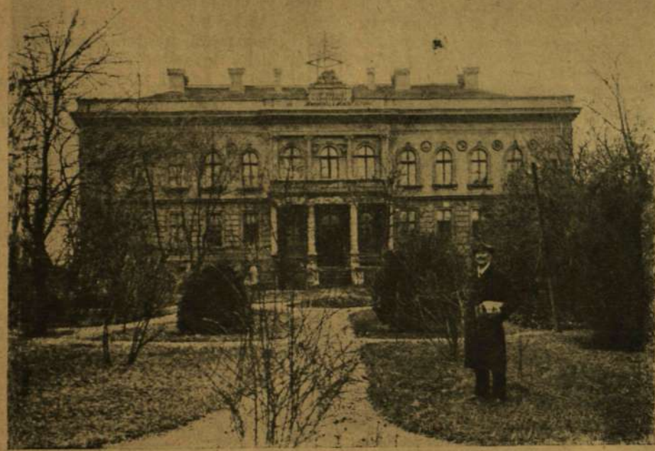
A HONVÉDMENHÁZ ÉPÜLETE.
