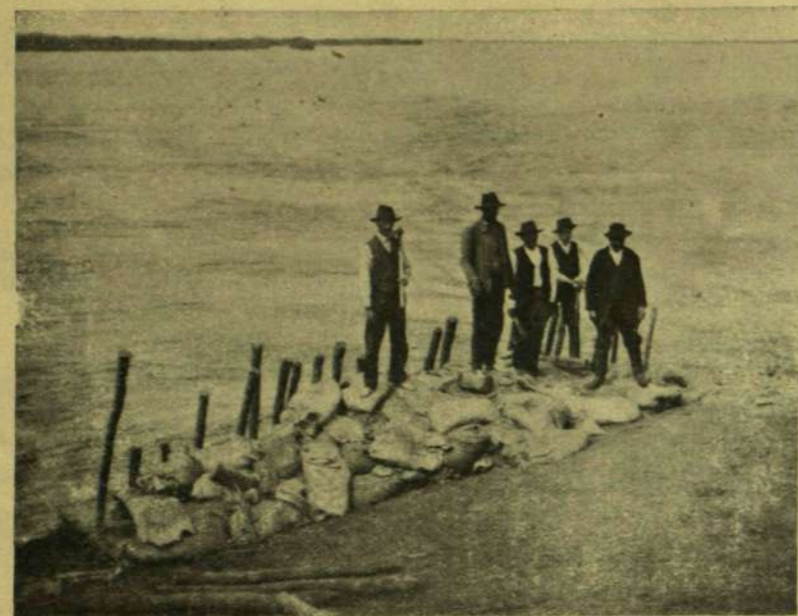
Gátszakadás a torontálmezei Csobán, melyet az emberek hasztalanul igyekeznek homokzsákkal betömni.
