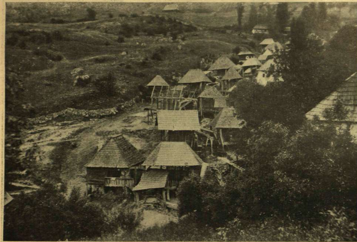
A TERRASZSZERŰEN ÉPÍTETT ZÚZDÁK.
