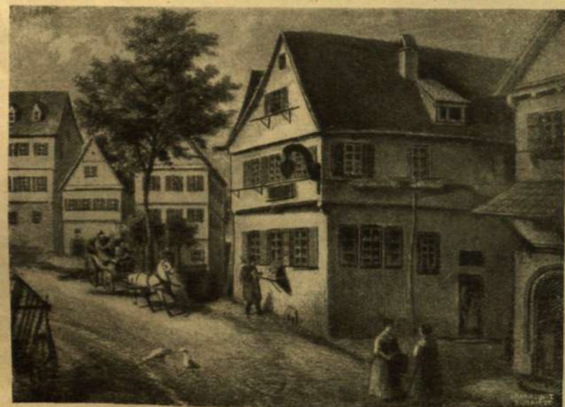
SCHILLER SZÜLŐHÁZA MARBACHBAN.
