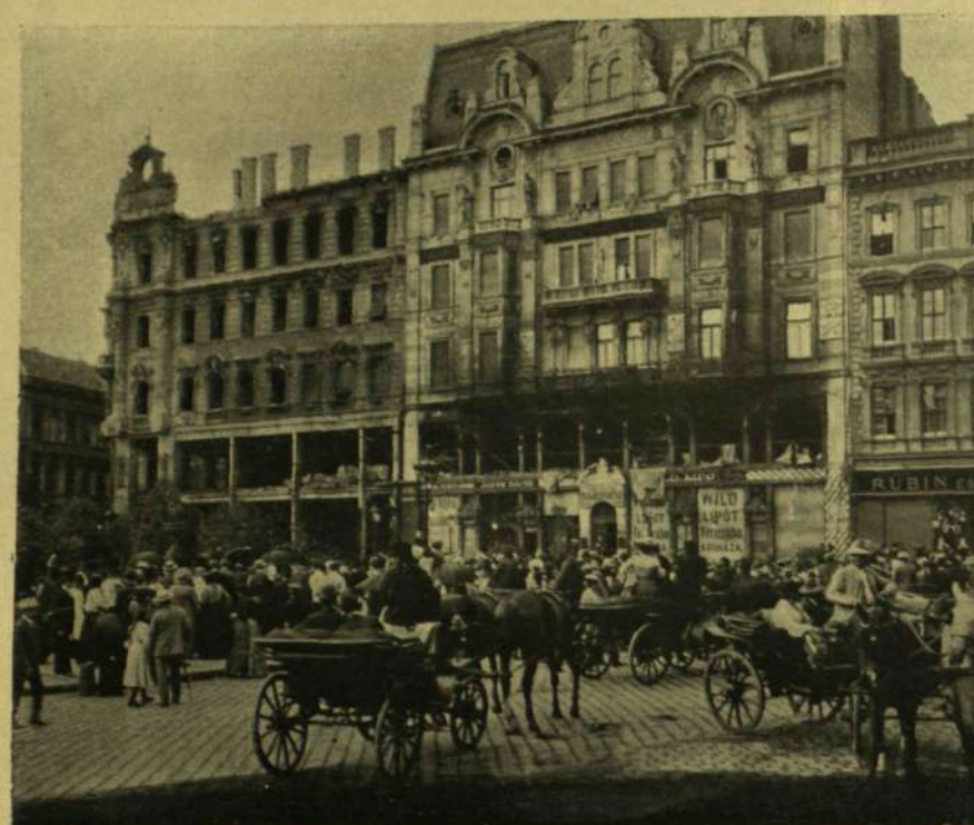
A «Párisi Áruház» és a kerepesi-úti szomszédház a tűz után.
