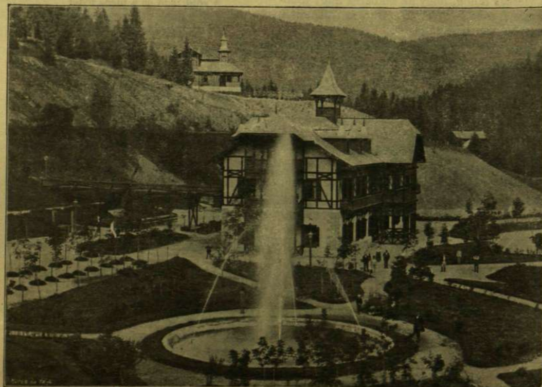
A «MILLENIUM» ÉPÜLET IGLÓ-FÜREDEN.
