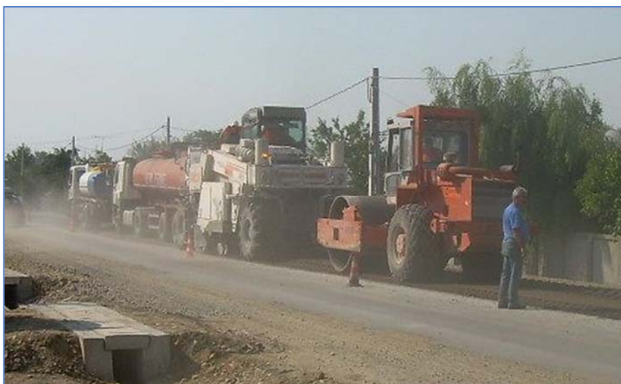
5. ábra Habosított bitumenes hidegremixhez használt géplánc
