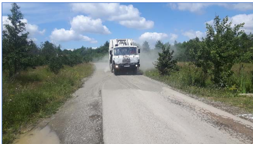
4. ábra Hidraulikus kötőanyag szórása
