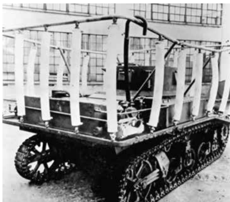
18. kép: Az M3E4 Stuart úszó könnyű harckocsi felhúzott ponyvával, illetve csupasz ponyvamerevítővel (NARA)
