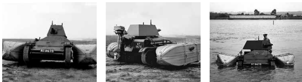
5. kép: Egy Vickers gyártmányú Light Tank Mk. IIA könnyű harckocsi Straussler-féle felcsatolható pontonokkal (IWM, KID 30, KID 59 és KID 51)
