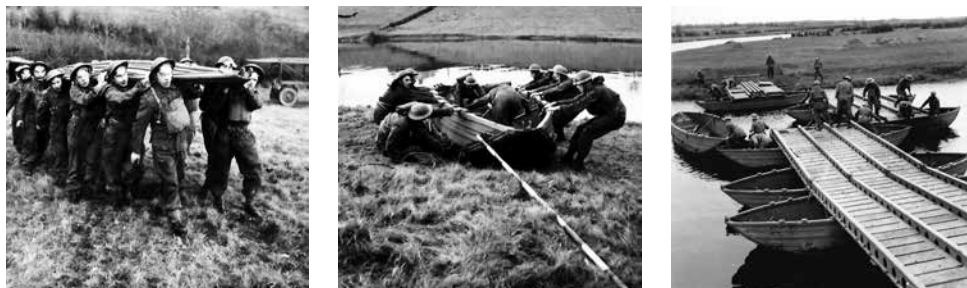
4. kép: Egy Straussler-féle összecsucskható hadihíd összeszerelését szemléltetik brit utászok 1941-ben (IWM, H 15711-15712 és H 9752)
