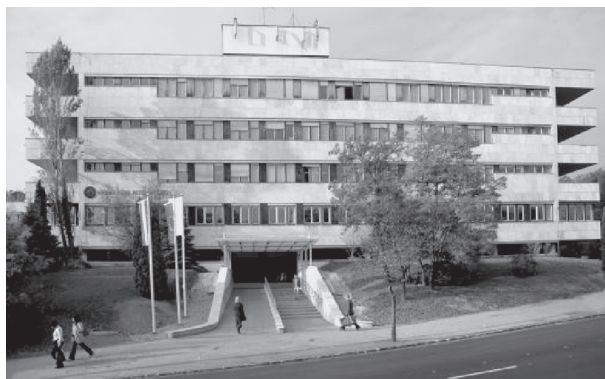
2. kép. A Pető Intézet Kútvolgyi úti épülete
