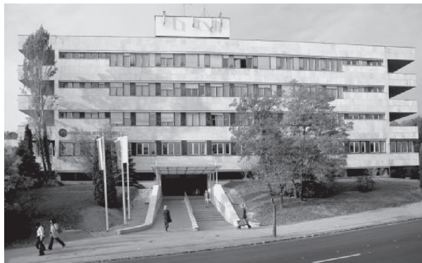
2. kép. A Pető Intézet Kútvolgyi úti épülete
